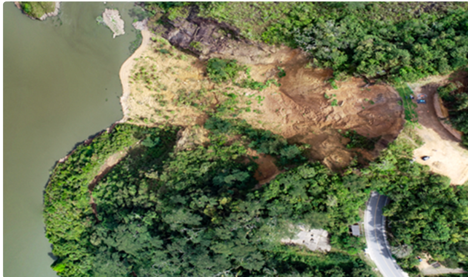
Panorámica del talud por intervenir
