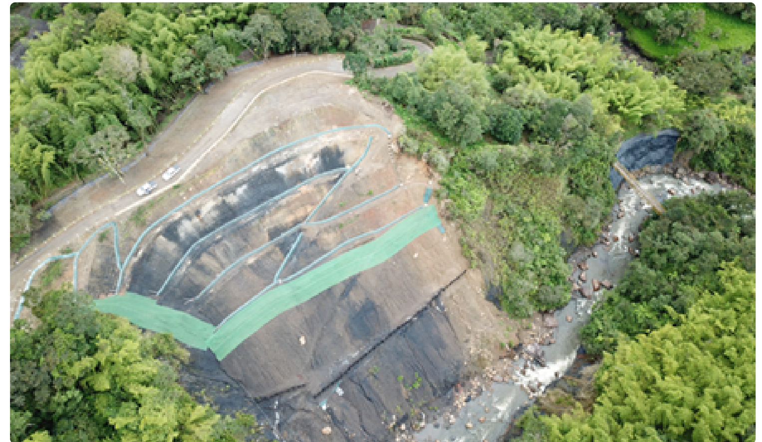
Panorámica de los taludes intervenidos QT2 y QT2-1
